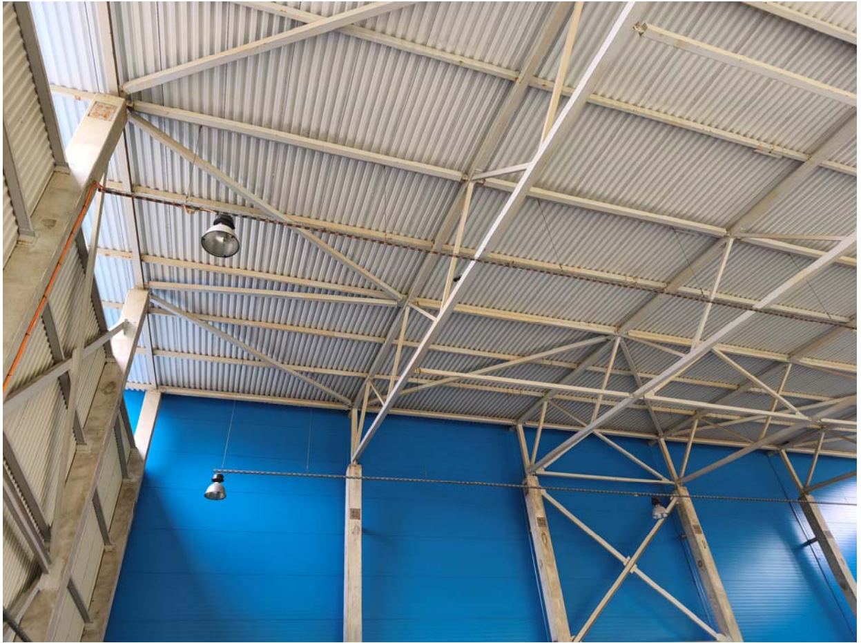
11 pav. Stogo konstrukcijų fotografacija
