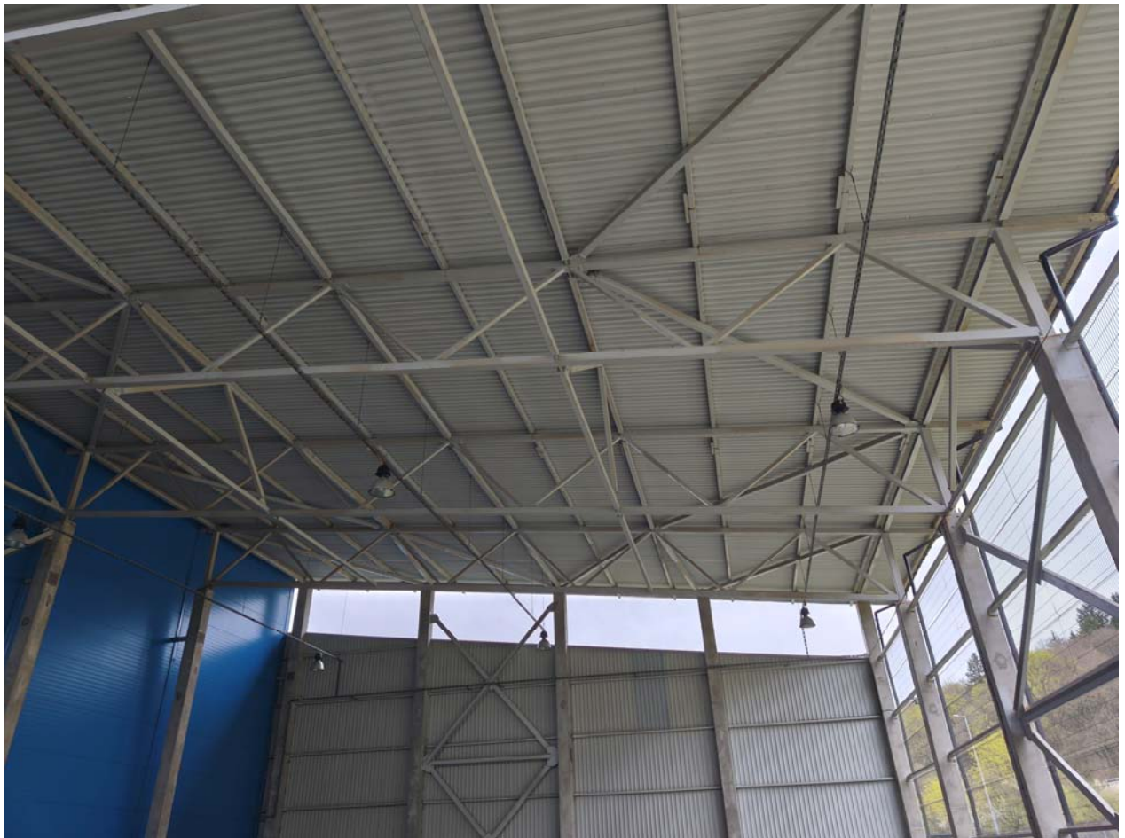
10 pav. Stogo konstrukcijų fotofiksacija
