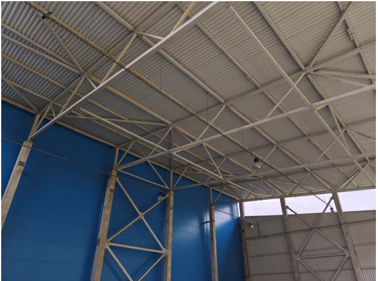
08 pav. Stogo konstrukcijų fotofiksacija
