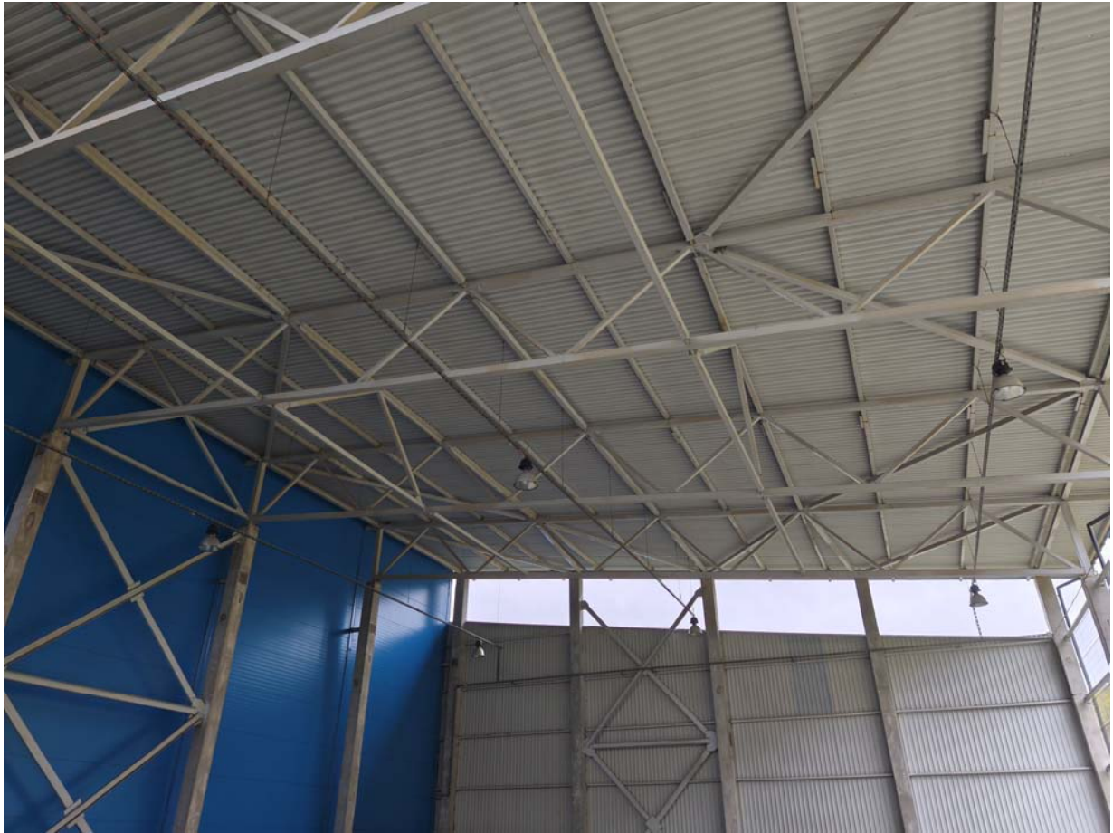
09 pav. Stogo konstrukcijų fotofiksacija
